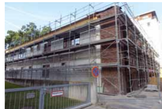
Baustelle Kita Oskar-von-Miller-Straße 2013
