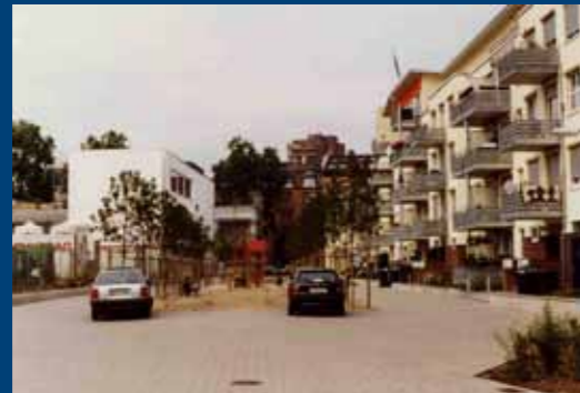
Oben links und rechts: Wohnhof Ostendstraße 30-42 2000
