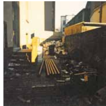
Uhlandstr. 56 vor der Modernisierung
