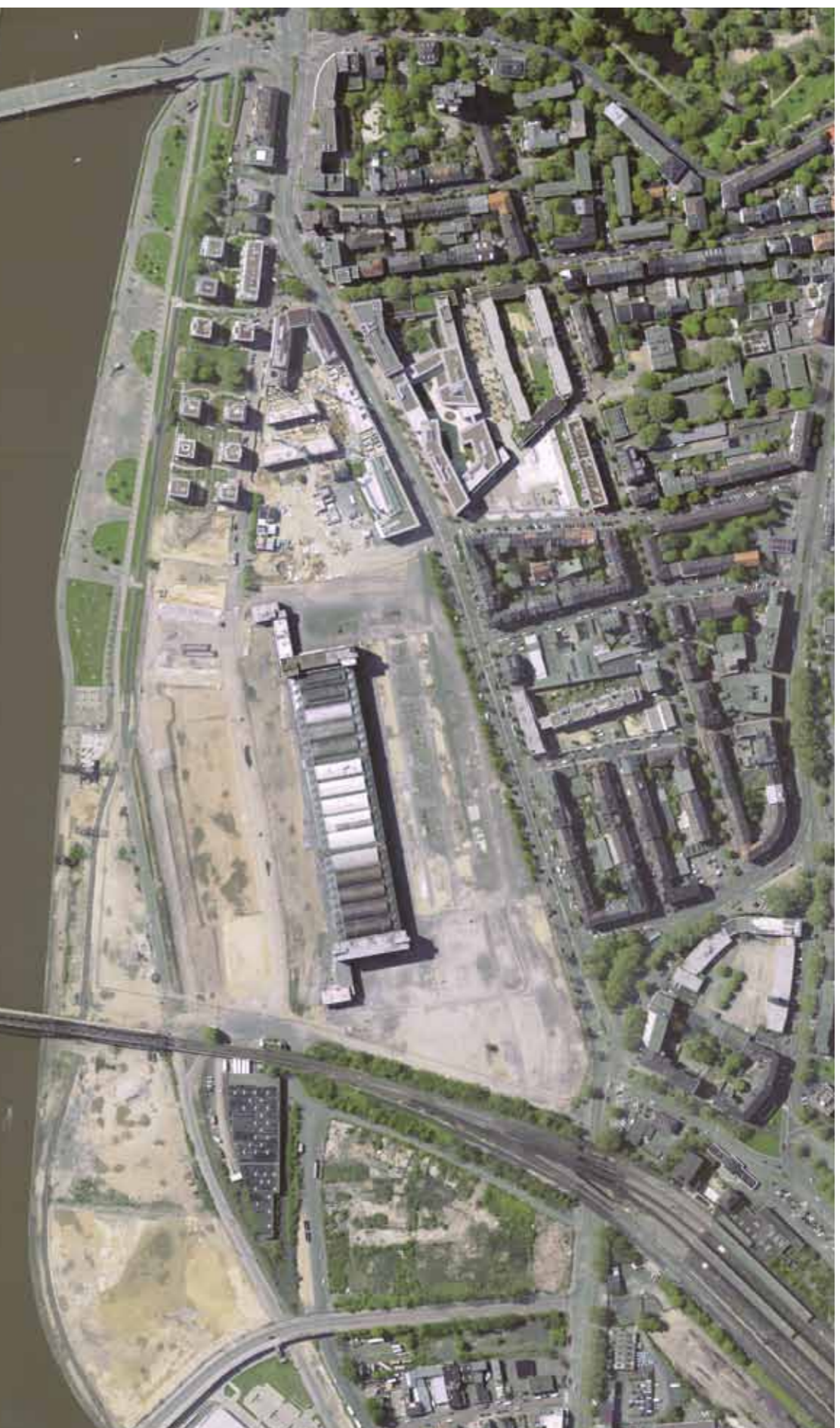
Luftbild 2005 (Quelle: Stadtvermessungsamt Frankfurt am Main)
