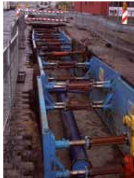
Leitungsverlegung Erschließung Oskar-von-Miller- Straße 2007/2008
