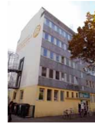
Ehemaliges Verwaltungsgebäude Stapf – heute Internationales Familienzentrum
