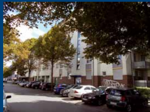
Oben links und rechts: Wohnhof Ostendstraße 30-42 2014
