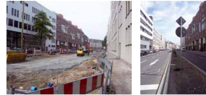
Bauarbeiten Erschließung Sonnemannstraße – Oskar-von-Miller-Straße – Rückertstraße 2005 und 2010
