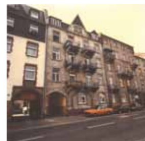
Windeckstraße 19 vor der Modernisierung
