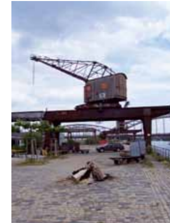
Kran vor der Sanierung 2006
