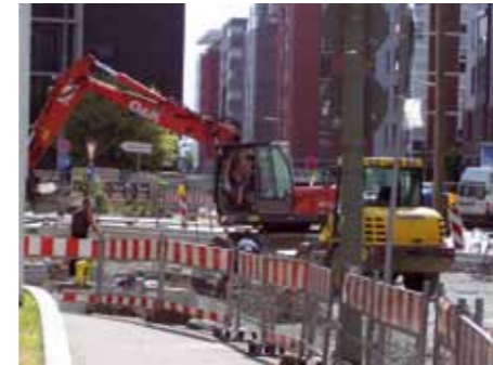
Erschließungsmaßnahmen Sonnemannstraße – Oskar-von-Miller-Straße 2008
