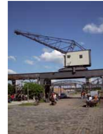
Kran nach der Sanierung 2009
