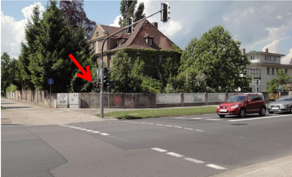
Abbildung 34: Hilfssignalgeber (gelbes Blinklicht) mit 200 mm Durchmesser an Fußgänger Furt schlecht zu erkennen
