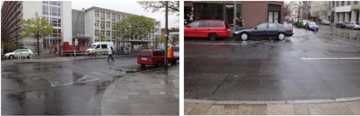
Abbildung 124: Knotenpunkt 14 – Schlechte Erkennbarkeit / keine Schutzfunktion der Aufstellfläche (Bild links) und zugeparkte Aufstellfläche an der Überquerungsstelle 2a (Bild rechts)
