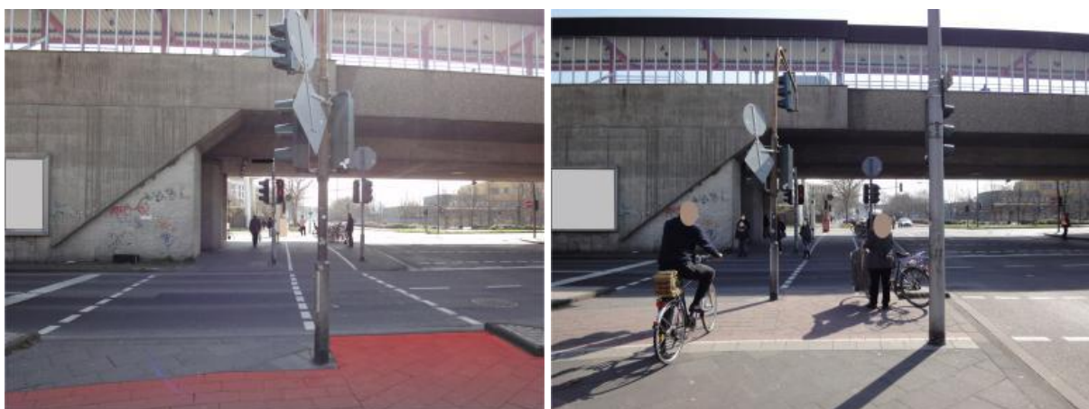
Abbildung 71: Knotenpunkt 5 – Aufstellflächen auf Dreiecksinsel am „Freien Rechtsabbieger“ aus Arm 3 in Arm 4 in Blickrichtung Südost (im Bild links ist der rot eingefärbte Bereich für den Radverkehr hervorgehoben)
