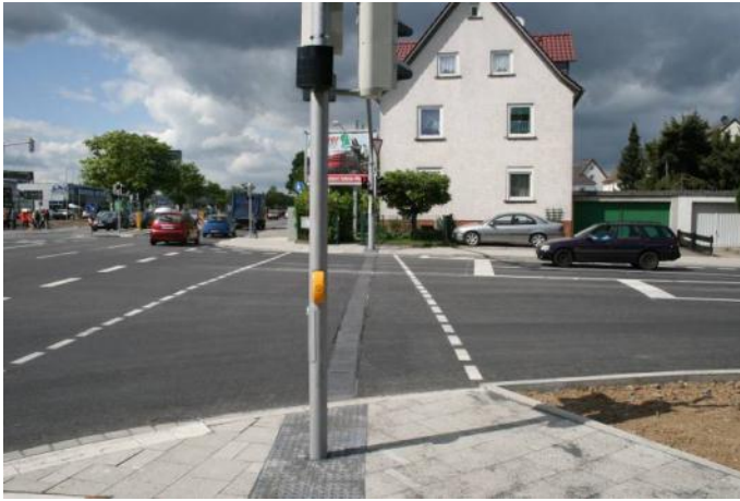
Abbildung 130: Taktile Leitstreifen im Fahrbahnbereich über eine lange Furt (Kassel) [Foto: Wiesenhütter, KVC]
