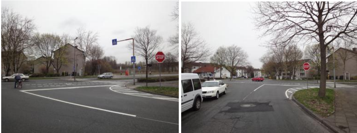
Abbildung 121: Knotenpunkt 13 - Neue Markierung und Verkehrsregelung der Zufahrt aus Arm 2
