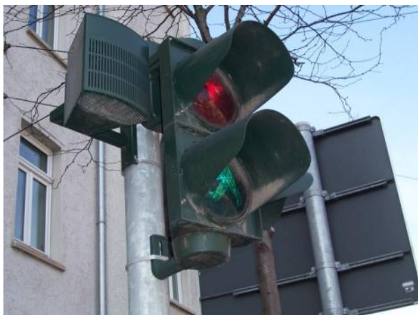
Abbildung 133: Schallgeber für ein akustisches Freigabesignal in Höhe der Signalgeber und in Furtmitte abstrahlend
