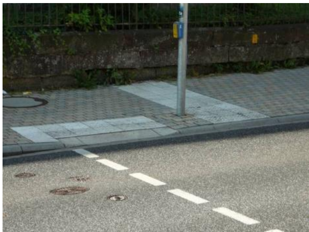
Abbildung 131: Überquerungsstelle mit differenzierter Bordhöhe, Sperrfeld und Auffindestreifen (hier mit Sonderbord) [Foto: Boenke]
