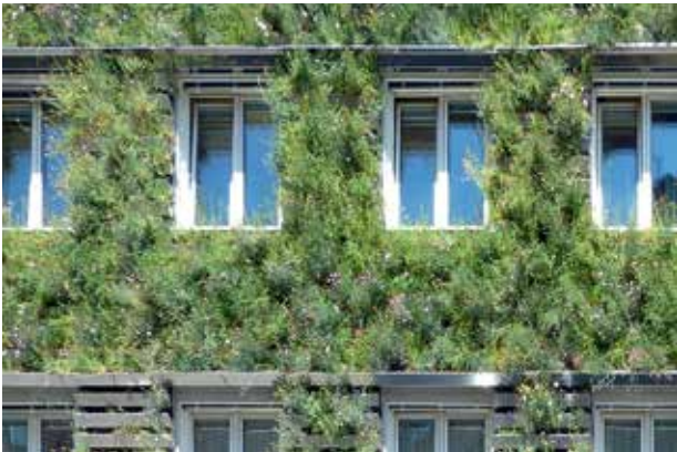
ABBILDUNG 3.2–4 ▶ Wandgebundene Fassadenbegrünung mit Dämmwirkung, Ausschnitt Fassade Magistratsabteilung 48, Wien. (Foto: Nicole Pfoser, 2012)
