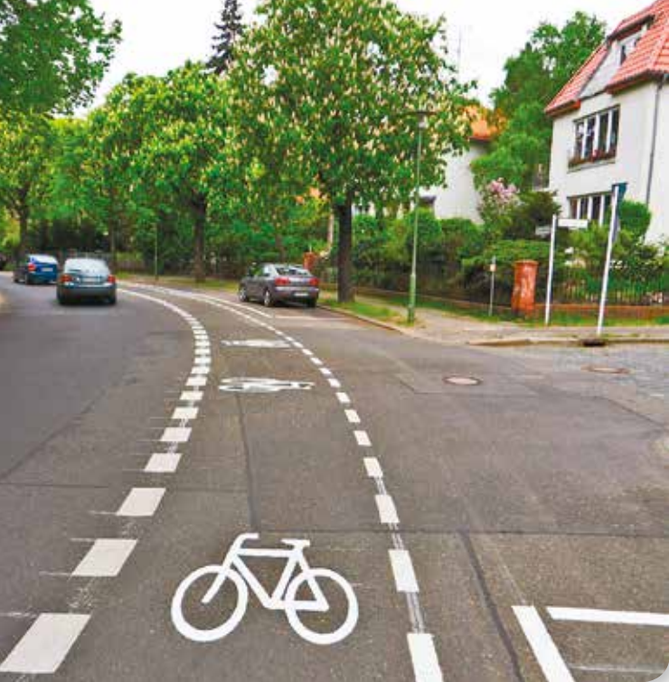
Deutliche Markierung der Radverkehrsführung
