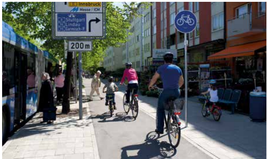
Bordsteinradwege sind ein sicheres Element eines Radverkehrsnetzes, wenn sie ausreichend dimensioniert sind und gute Sichtverhältnisse an den Knotenpunkten aufweisen
