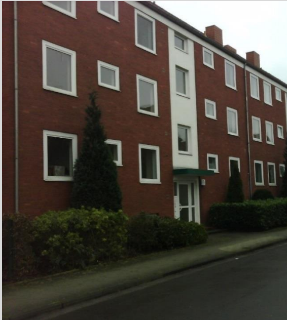
Neißebrasse – Wohngebäude aus den 1960er Jahren vor dem Umbau
