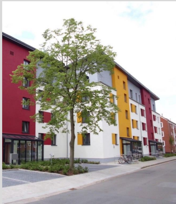
Neißebrasse – nach dem Umbau zur barriere- freien Wohnanlage
