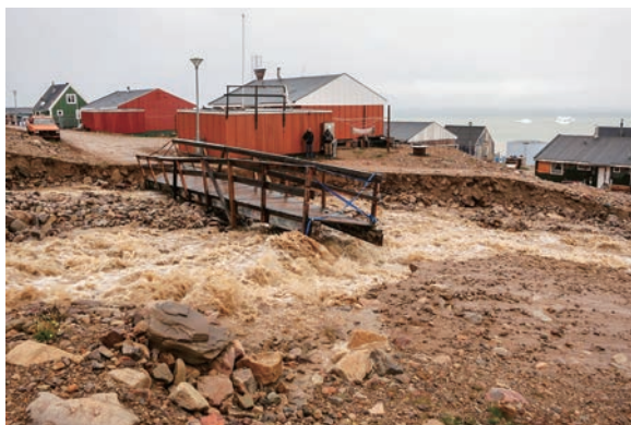
Мост, разрушенный разливом реки, стекающей с ледника недалеко от посёлка Канак (Фото С. Сугияма, Гренландия)
