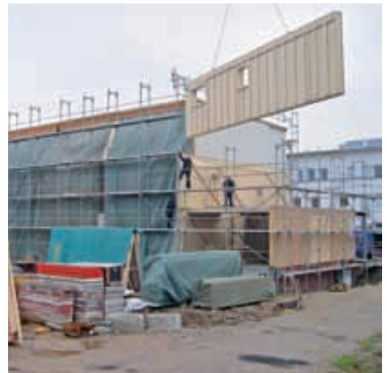
Anbringen der bereits vorgefertigten Holztafelelemente
