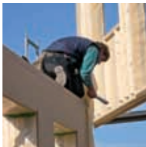
Anbringen der bereits vorgefertigten Holztafelelemente
