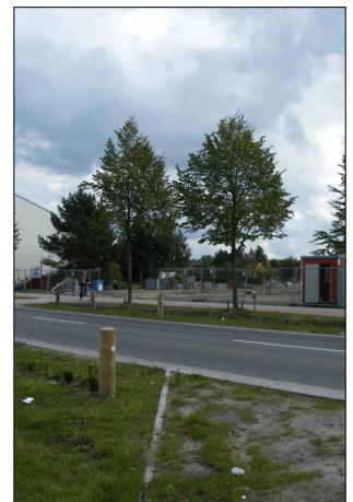
Abb. 9: Baustelle B-Plan 65 „Grimmer Str.“
