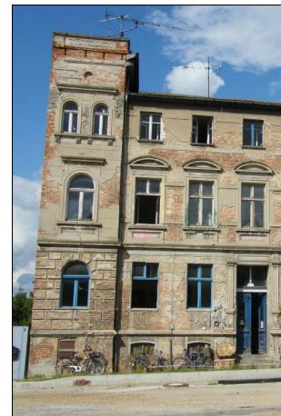
Abb.14: gefährdete gründerzeitliche Architektur
