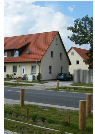
Abb.19: Wohnungsneubau direkt an stark befahrener Straße
