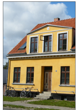
Abb. 4: Gründerzeitbebauung Loitzer Straße
