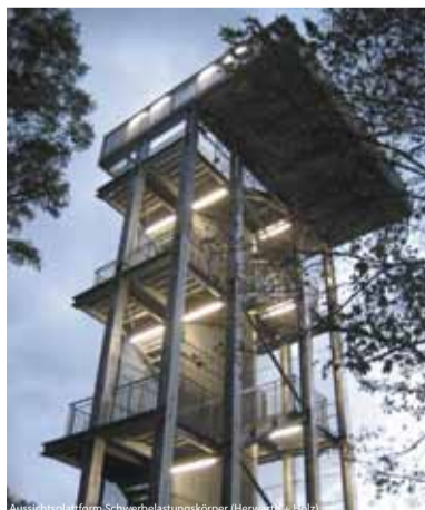
Aussichtsplattform Schwerbelastungskörper (Herwarth + Holz)
