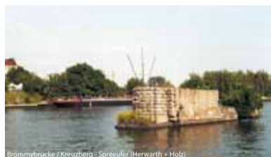
Brommybrücke / Kreuzberg - Spreewufer (Herwarth + Holz)
