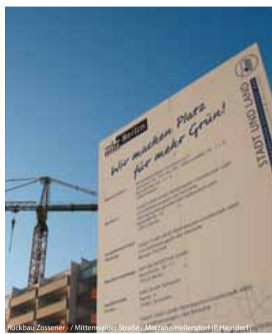
Rückbau Zossener - / Mittenwaldcr Straße / Marzahn-Hellersdorf (P. Harndorf)
