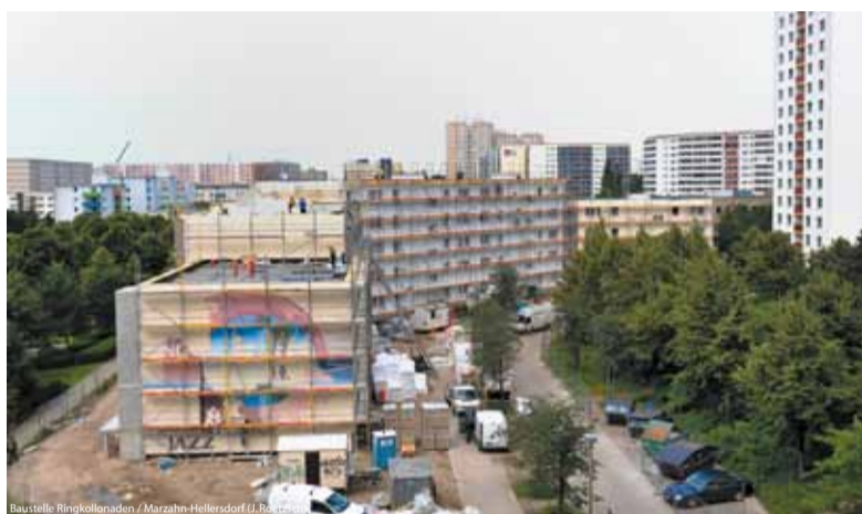
Baustelle Ringkollonaden / Marzahn-Hellersdorf (J. Ratzlaff)
