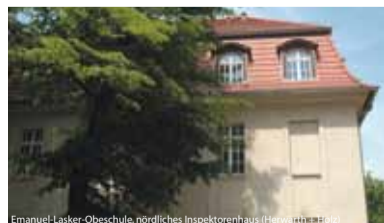
Emanuel-Lasker-Oberschule, nördliches Inspektorenhaus (Herwarth + Holz)
