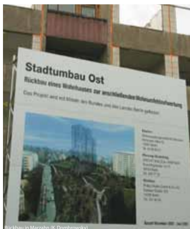
Rückbau in Marzahn (K. Dombrowsky)
