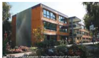
Nachbarzentrumshaus Kastanien / Marzahn-Hellersdorf (P. Hausdorf)
