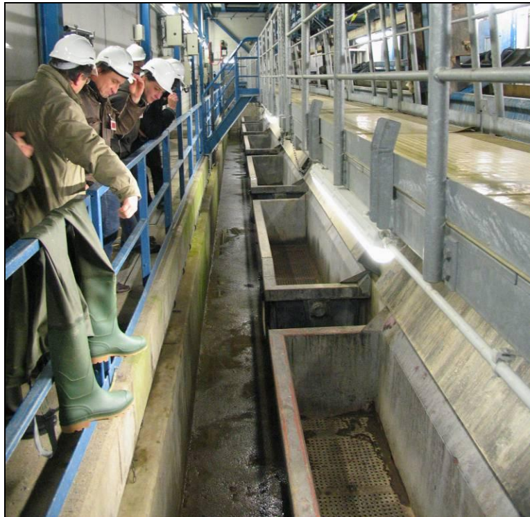
Abb. 5.40: Das am Feinrechen anfallende Treibgut wird separat von der Rechenreinigungsanlage auf ein Förderband geworfen, über das es einer Schredderanlage zugeführt wird; hier können im Rechengut enthaltene Fische abgesammelt werden
