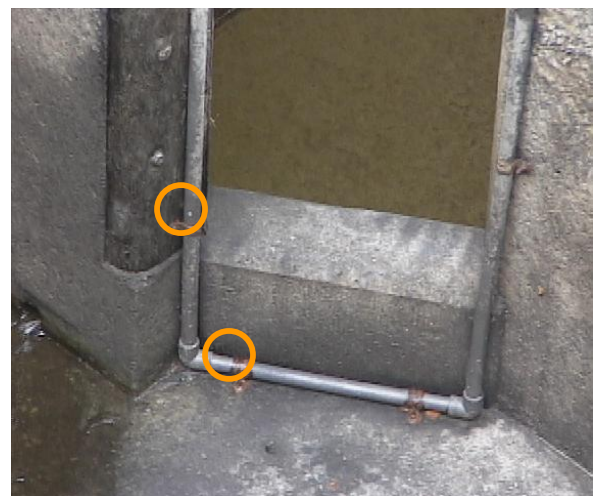
Abb. 5.78: Zum Schutz wird das Antennenkabel in ein PVC-Rohr mit 30 mm Durchmesser eingezogen. Die Befestigung erfolgt mit rostfreien Clips, die im Beton verdübelt werden (Foto: A. Haro)
