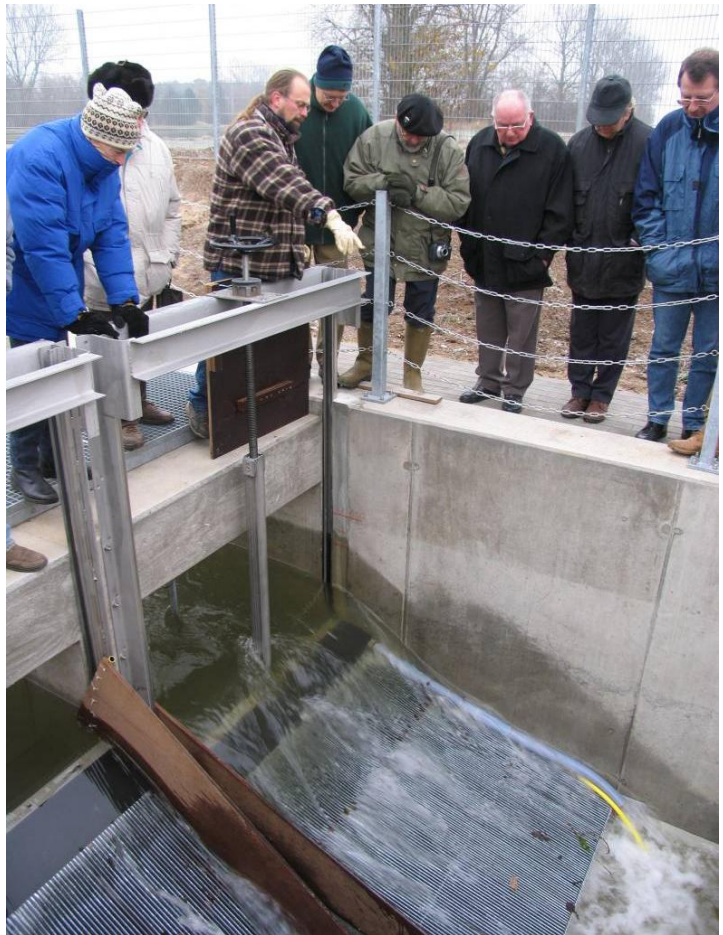
Abb. 5.36: Tiroler Wehr im Aalby-pass des Wasserkraftwerks Dettelbach am Main (Bayern)
