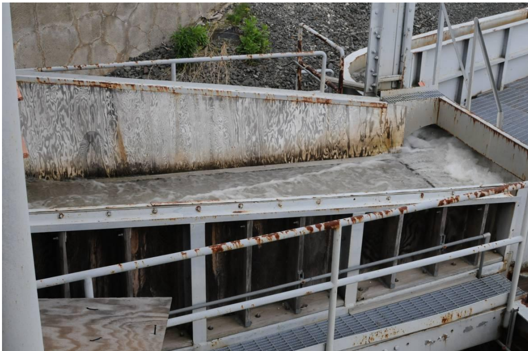
Abb. 5.31: ... auf diese Weise wird das Tiroler Wehr stets so beaufschlagt, dass die Fische in einem geringen Restvolumen die am Ende des Rechens quer verlaufende Bypaßrinne erreichen, von wo aus sie über eine Rinne (oben rechts im Bild) zu einer Kontrollstation weitergeleitet werden
