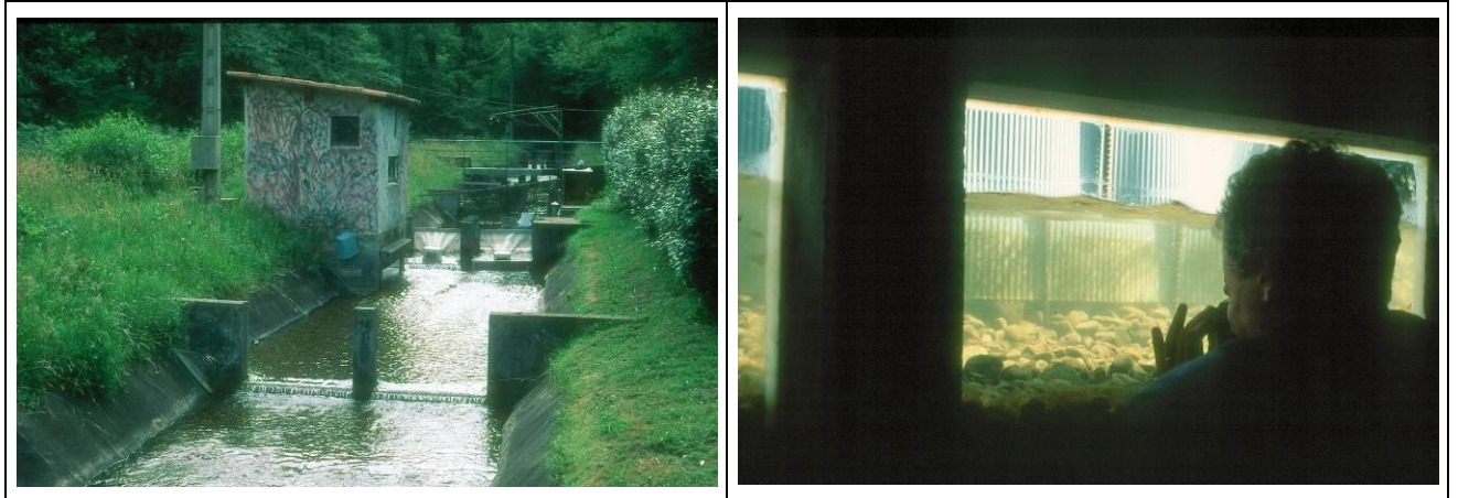
Abb. 5.1: Künstlicher Beobachtungskanal an der Nivelles (Frankreich) und Blick aus der Beobachtungsstation ins Gerinne
