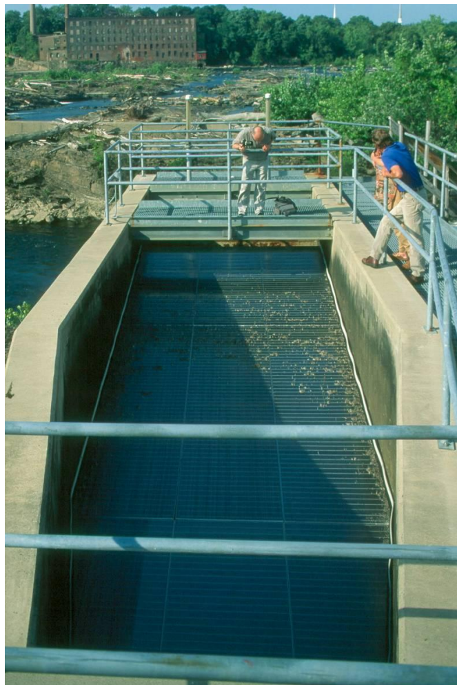
Abb. 5.32: Tiroler Wehr mit einem Wedge-Wire-Screen von 1 mm lichter Weite zur Überwachung der Abwanderung atlantischer Lachssmolts am Wasserkraftwerk Holyoke am Connecticut River (USA)
