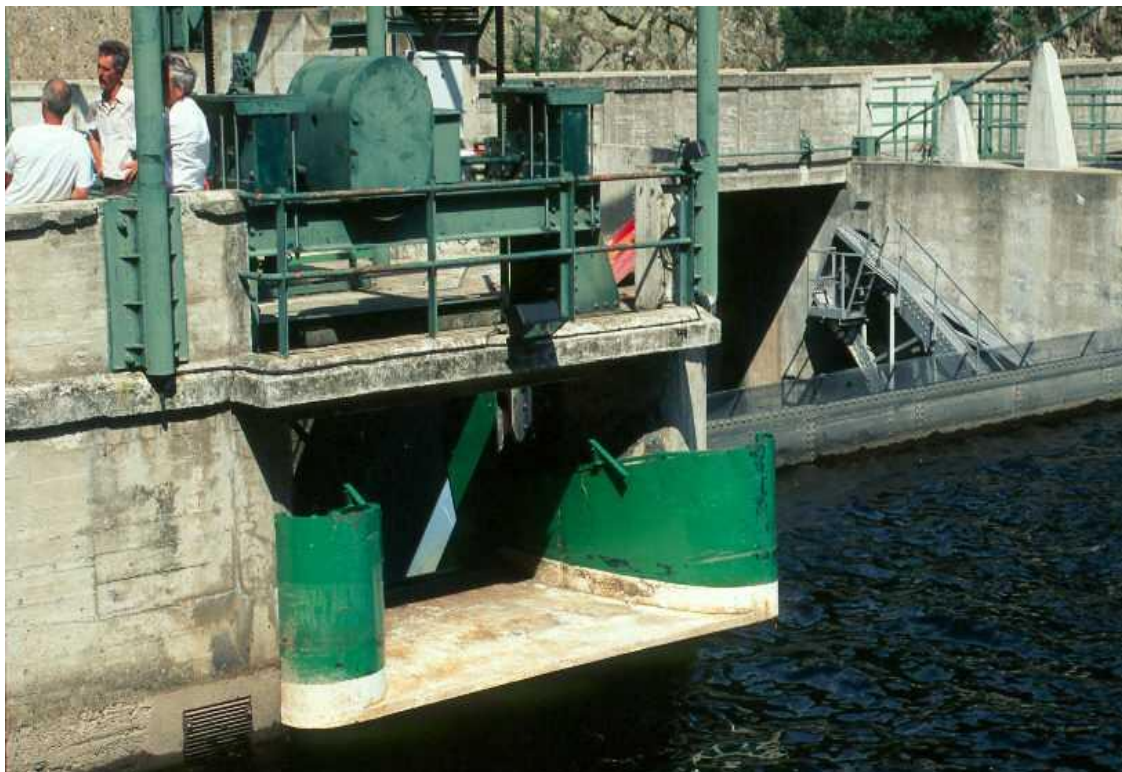
Abb. A.4: Bypass-Düse für atlantische Lachsmolts mit Beleuchtung zur Verbesserung der Attraktionswirkung: Der Einlauf des Bypasses am Staudamm Poutès im Allier ist so geformt, dass möglichst geringe Turbulenzen entstehen und die Strömung stetig beschleunigt wird. Der Bypass ist höhenverstellbar und kann so an wechselnde Oberwasserstände angepasst sowie außerhalb der Betriebszeiten über die Wasseroberfläche emporgehoben werden.
