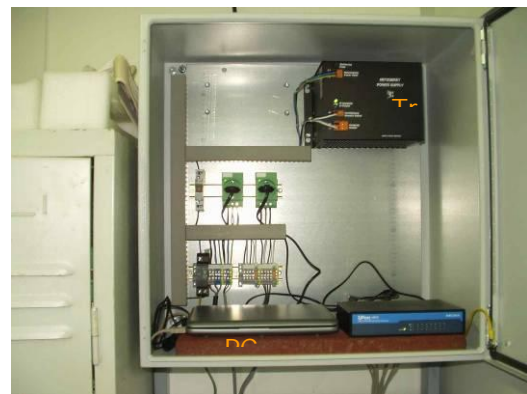
Abb. 5.84: Deutsche Weiterentwicklung der HDX-Technologie; rechts: kompakter Schaltschrank mit 8 Lesegeräten; links: dazu gehöriger Schaltschrank mit Transformator und PC sowie Überspannungsschutz und Sicherungen
