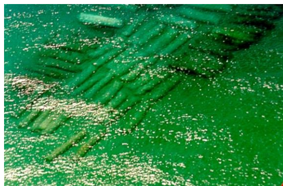
Abbildung 11: Geotextile Container und Tubes (Quelle: http://specialtyfabricsreview.com/articles/1209_sw3_reef.html )
