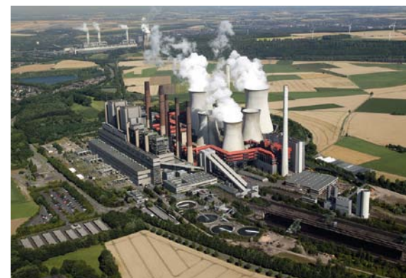
Kraftwerk Neurath – drei Generationen von Blöcken an einem Standort (Nordrhein-Westfalen) Foto: Archiv RWE Power
