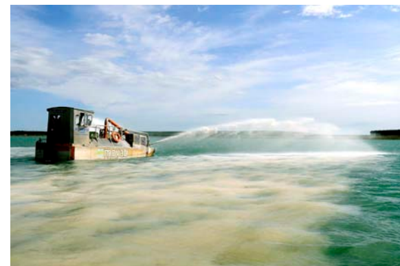
Einsatz eines Sanierungsschiffs zur Neutralisierung im Lausitzer Seenland (Brandenburg/Sachsen) Foto: Archiv LMBV mbH
