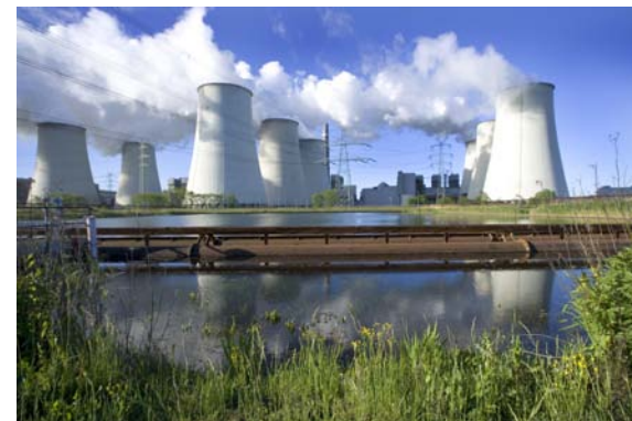
Kraftwerk Jänschwalde mit nachgerüsteter Rauchgasentschwefelung (Brandenburg) Foto: Archiv Vattenfall
