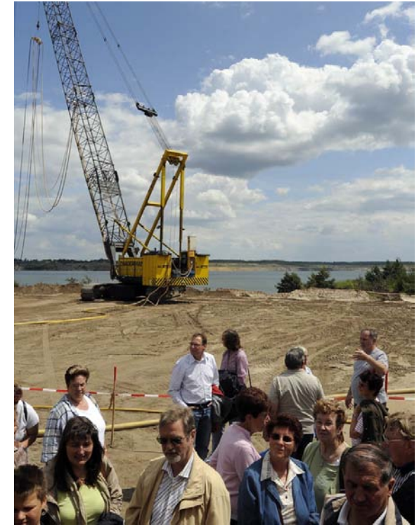
Innovative Sanierungstechnologien - Rüttel- druckverdichtung in Kippenbereichen (Brandenburg/Sachsen) Foto: Archiv LMBV mbH
