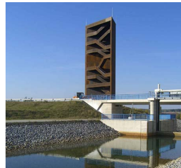
Landmarke und Aussichtsturm „Lausitzer Seenland“ – der „Rostige Nagel“ (Brandenburg) Foto: Archiv LMBV mbH
