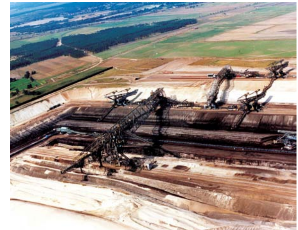
Tagebau Welzow Abraumförderbrücke vom Typ F60 (Brandenburg) Foto: Archiv Vattenfall
