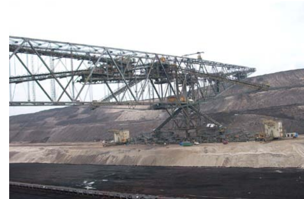
Tagebau Nochten Abraumförderbrücke vom Typ F60 (Sachsen – Lausitz) Foto: Berkner
