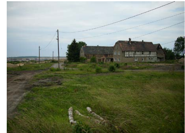
Ortslage Heuersdorf – Abrissarbeiten 2009 unmittelbar vor dem Umsiedlungsabschluss (Sachsen – Mitteldeutschland) Foto: Berkner
