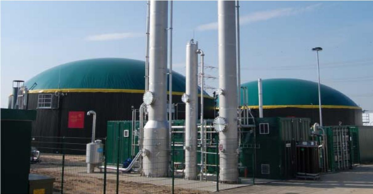
Anlage zur Einspeisung von Biogas in das Erdgasnetz – Druckwasserwäsche und Übergabestation
