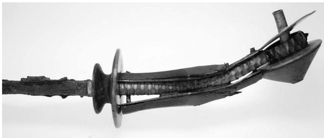
Figura 10. Détail de la soudure.
