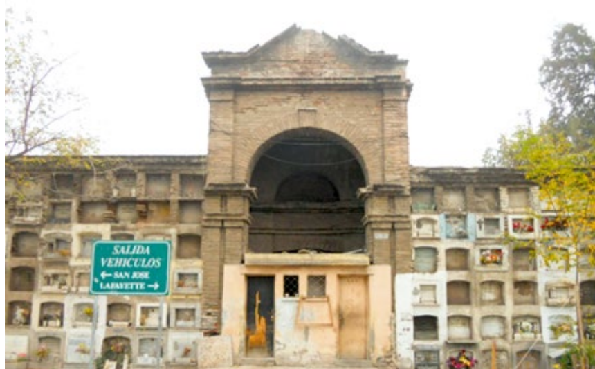
Figura 4. Vista de la portada Limay desde el cementerio Fuente: autoras
