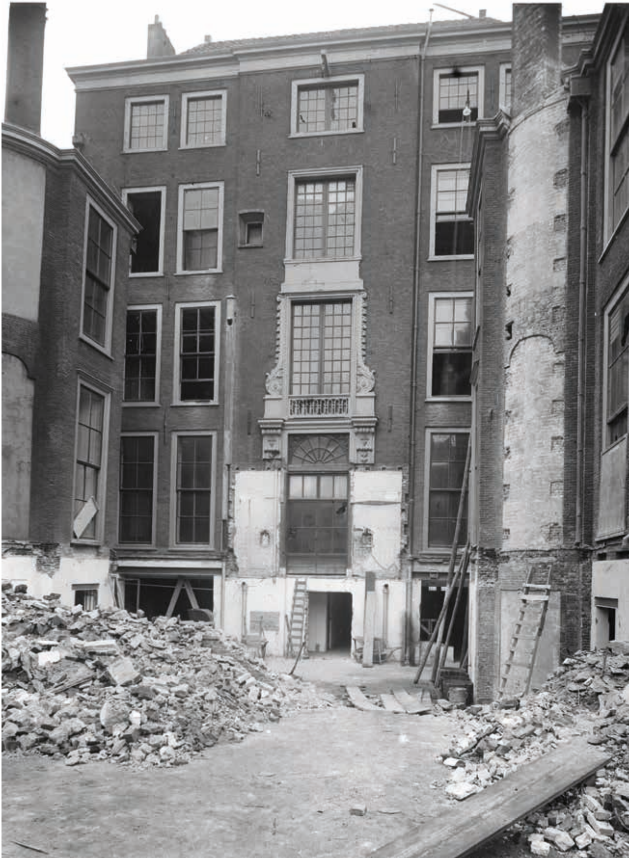
7. Achtergevel van Korte Vijverberg 3 tijdens de restauratie, 1943. De twintigste-eeuwse aanbousels zijn al afgebroken. De negentiende-eeuwse ramen zijn nog wel aanwezig, foto E.M. van Ojen (Haags Gemeentearchief)
