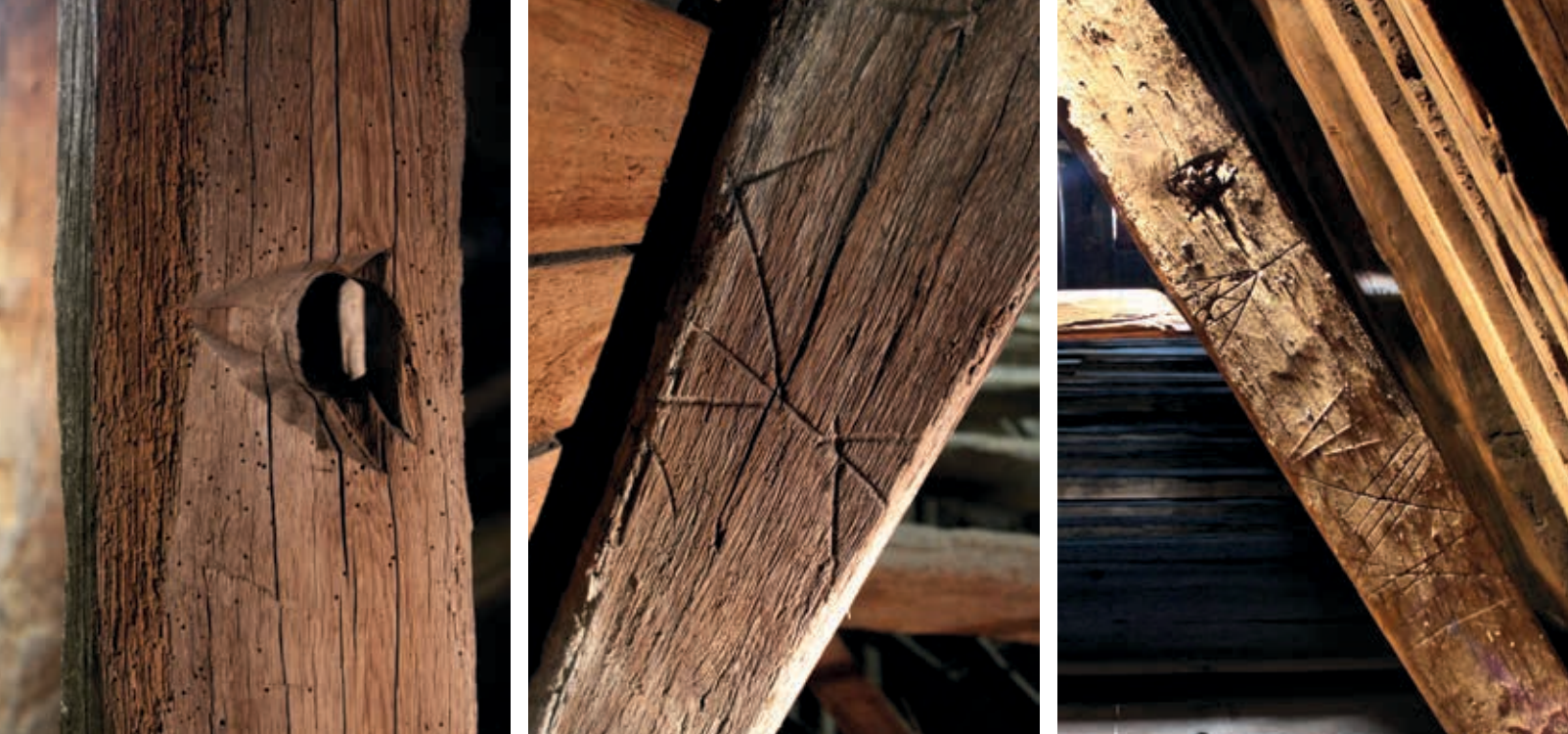
7. A Een volledig intacte vlotverbinding; B Een handels- of eigendomsmerk. Beide foto's zijn afkomstig uit de dakkap van het schip van de parochiekerk van Mariakerke nabij Gent (1278-1288 (d)); C Complexe handelsmerken uit de kap van het stadhuis van Brugge (1365-1387 (d))
