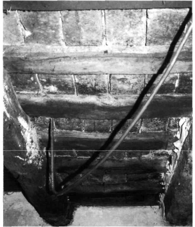
Afb. 5. Onderaanzicht van een 'bakstenen vloer' in het pand Schoolstraat 3/5 te Groningen, bestaande uit een enkelvoudige balklaag, ribben of 'kinderbinten' en een vloerlaag van bakstenen (foto J.A. van der Hoeve, 1996).
