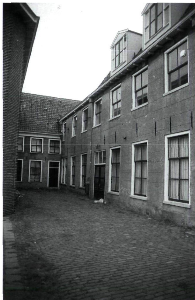
Afb. 2. Zuidelijke zijgevel van het hoofdgebouw (rechts) en oostgevel van de dwarsvleugel (op de achtergrond). De begane grond van het hoofdgebouw is in 1500 gebouwd als magazijn op het blokhuis. Ook een gedeelte van de balklaag boven de begane grond behoort tot deze bouwphase. De dwarsvleugel stamt uit 1851 (dia J.A. van der Hoeve, 1997).
