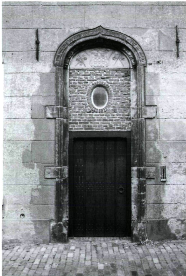
Afb. 3. Het poortje in de zuidgevel van het hoofdgebouw, dat is samengesteld uit onderdelen van verschillende herkomst. De ezelsrugboog dateert uit 1546, zo valt op te maken uit de tekst: “is god mit ons vie kan dan - 1546 - tegen ons cin niemant e”(: als God vóór ons is, wie zal tegen ons zijn?) (foto J.A. van der Hoeve, 1997).
