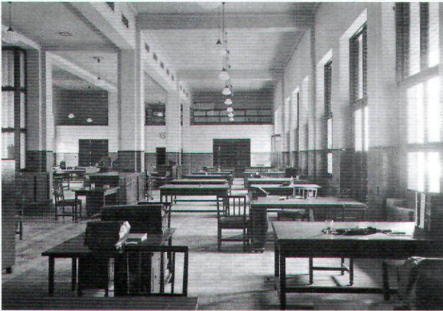
Afb. 18 Interieur factorij Batavia kantoren, 1933 (AMRO-archief in Weesp)
