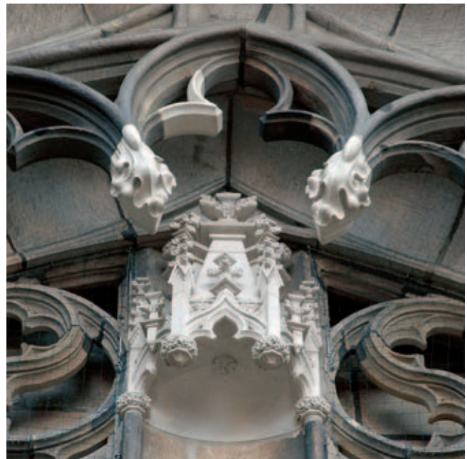
Afb. 12. Versiering met bladmotief op de toten van de driepassen aan de spitsboog boven de ingang van het noordertransept en een baldakijn uitgevoerd in Portland (foto februari 2008)
