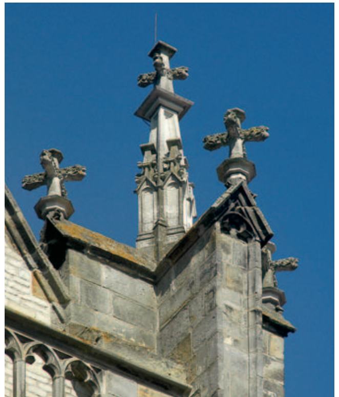
Afb. 9. Pinakel en kruisbloemen in Portland kalksteen op de oostelijke steunbeer van het zuidertransept van de Maria-Magdalenenkerk te Goes (foto september 2009)
