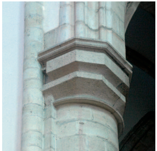
Afb. 7. Kapiteel op de muurpijler op de kruising van het noordertransept en de kooromgang in Saint Pierre Aigle (foto september 2009)
