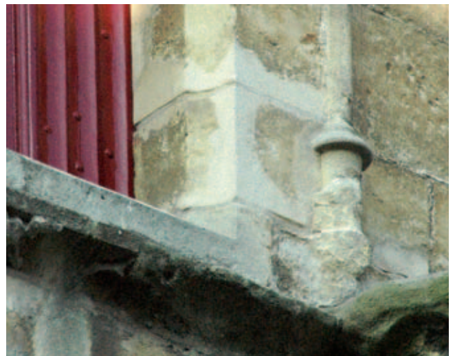
Afb. 16. Mortelreparatie (Jahnmortel) aan het Stadhuis te Tholen
