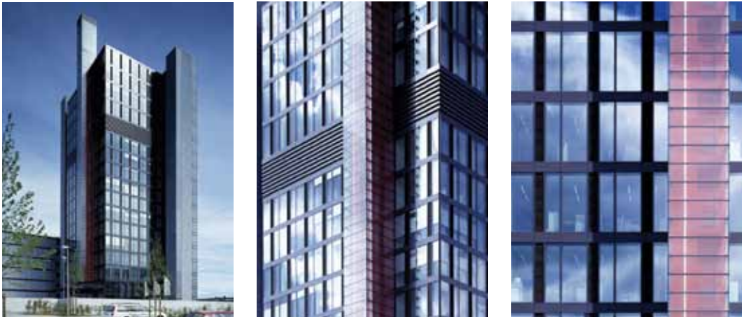
Figure 89 Debitel Stuttgart, RKW Architektur + Städtebau, Stuttgart
