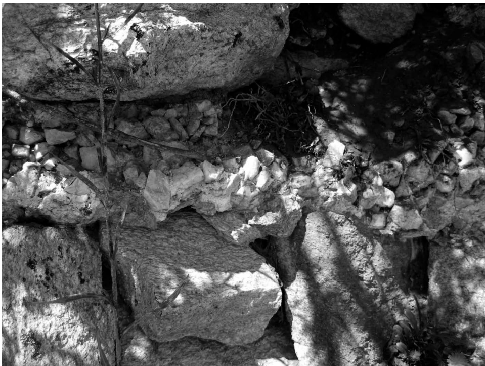
Figura 10. Detalle da cimentación revestida co opus signinum .
