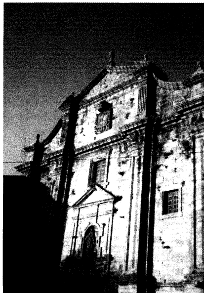
Fig. 18. Fachada de la iglesia. Siglo XVIII.
