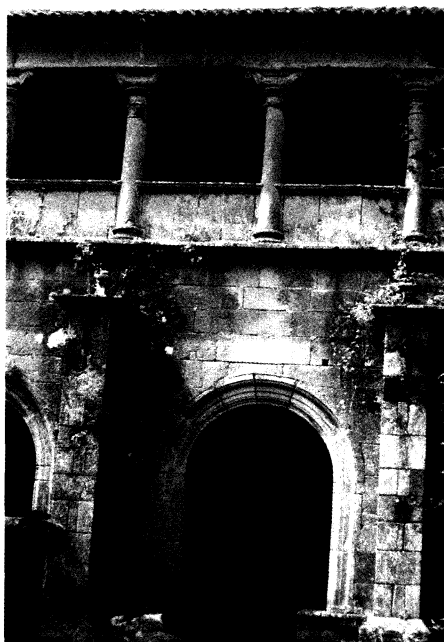
Fig. 6. Alzado de las galerías del claustro. Siglo XVI.
