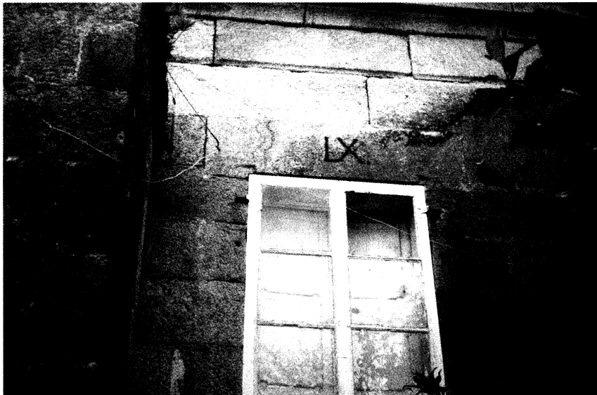
Fig. 17. Parte del epígrafe («LX») sobre el dintel de una de las ventanas que cierran la galería sur por el costado oriental. La inscripción (Año de 1768) recorre varios dinteles de puertas y ventanas de la galería sur en la fachada de la Huerta.
