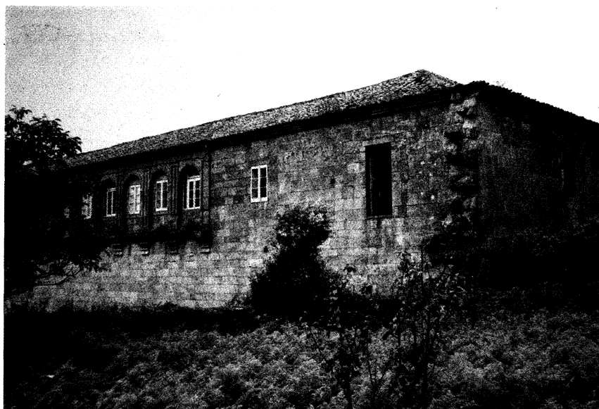
Fig. 11. Galería norte abierta al patio de los Naranjos. Remate oriental.
