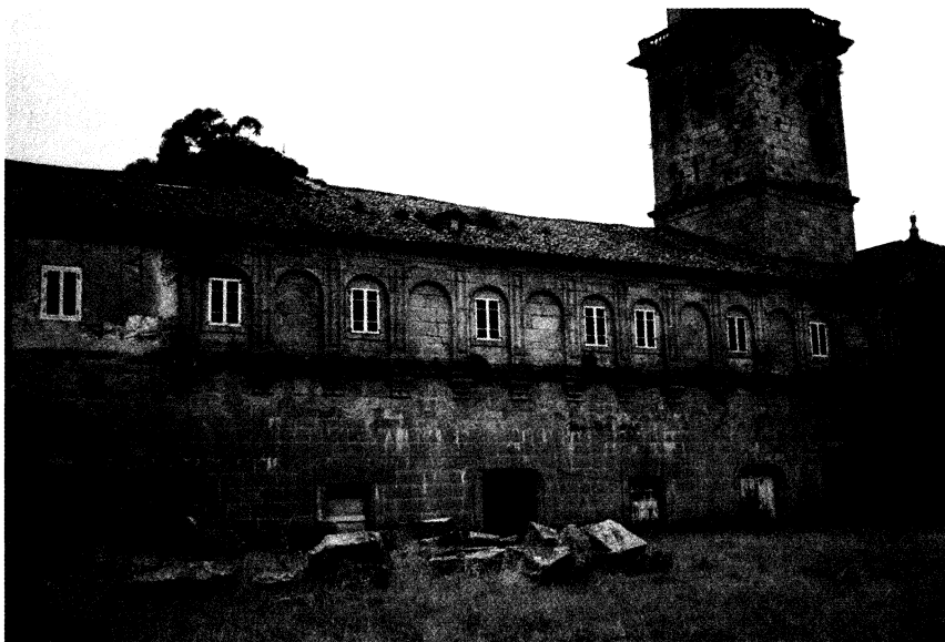
Fig. 13. Galería sur abierta al patio de los Naranjos y torre de la iglesia en el costado occidental.
