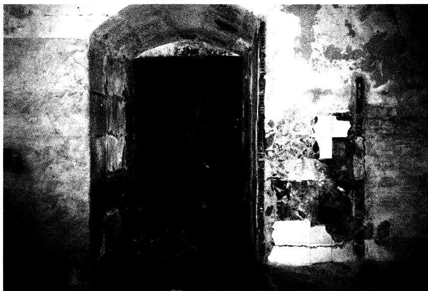
Fig. 14. Puerta tapiada, de acceso a un pasadizo, en la última habitación del costado oriental de la galería sur.
