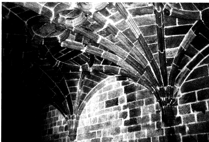
Fig. 7. Bóvedas del refectorio. Siglo XVI.
