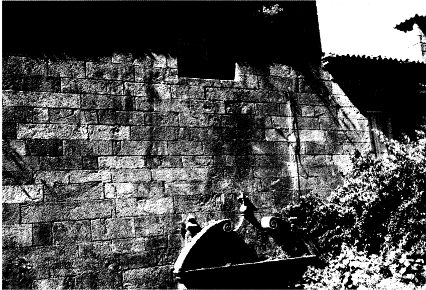
Fig. 16. Portada de acceso al patio de los Naranjos desde la Huerta a través de un zaguan abovedado.
