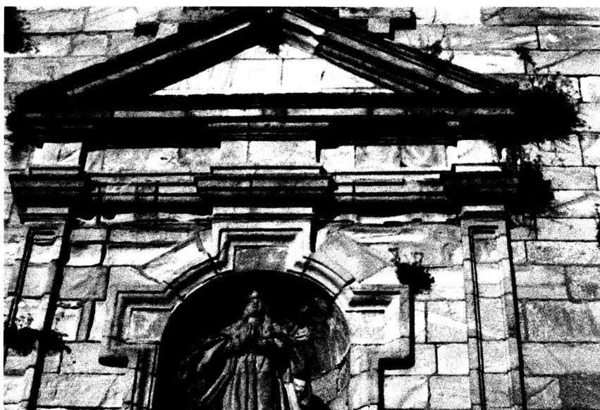
Fig. 19. Fachada de la iglesia. Detalle del frontón de la calle central con la hornacina de la Virgen y huellas de la inscripción: «Se pintó (?)» (izquierda) «Año de 1799» (derecha).
