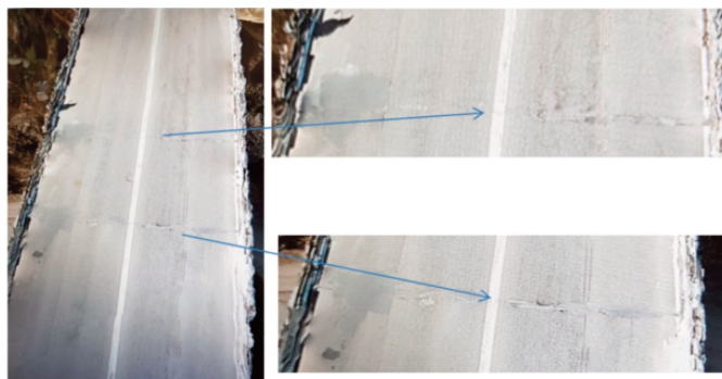
Fig. 5 - Texture del ponte di Villa San Giovanni rilievo da drone (fonte: propria elaborazione)
