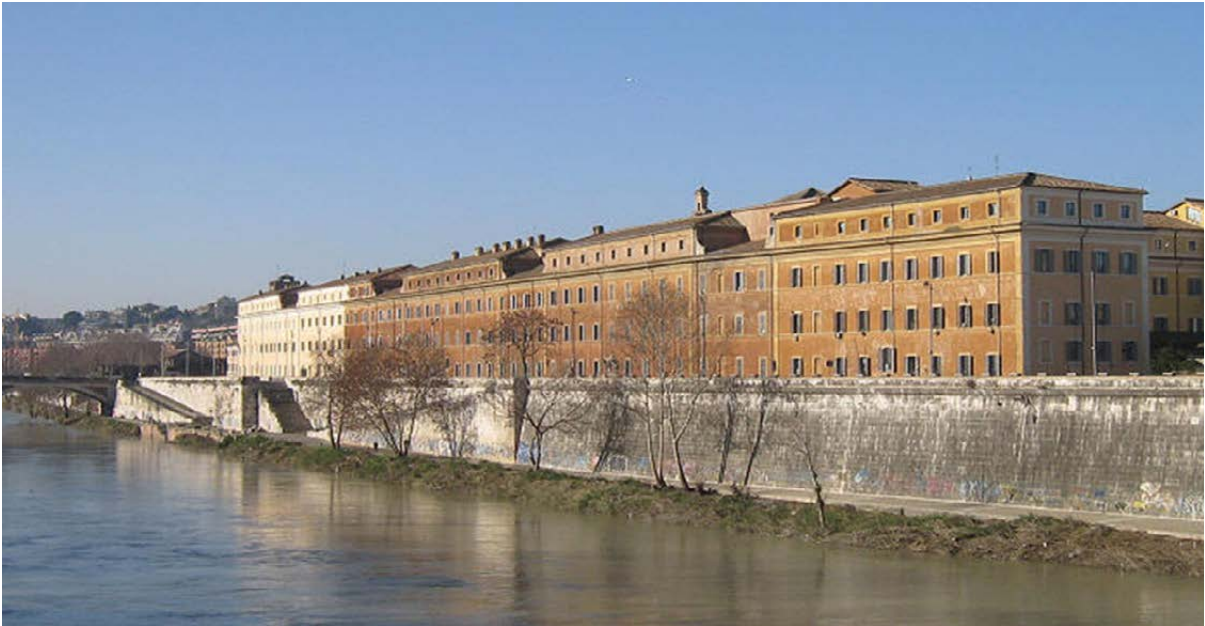
Figura 15. Roma. Complesso di San Michele a Ripa Grande. Fronte lungo il Tevere, http://aloe.architettriroma.it/visita-al-san-michele-a-ripa-grande/ (ultimo accesso 10 giugno 2016).
