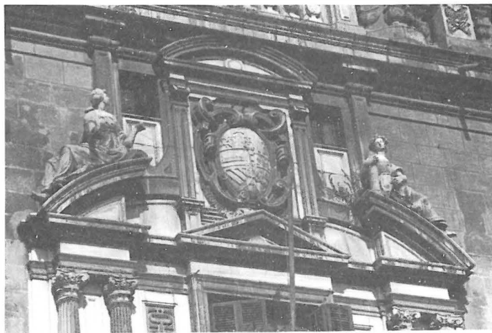
Chancillería. Detalle del cuerpo superior de la fachada
