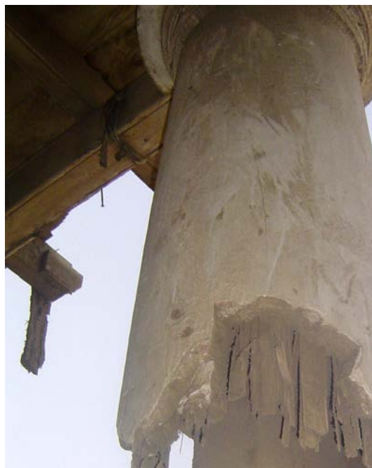
1 y 2. Construcciones en adobe y quincha en la Casa Punchauca, Carabayllo, sistema constructivo que llegó a estar prohibido.
