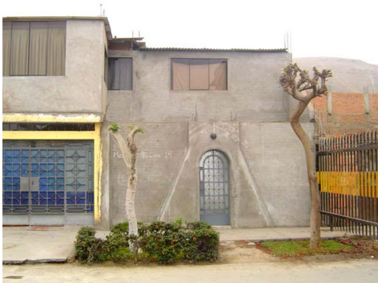
4. Casa particular en construcción en Los Olivos (Lima), con un sistema de jambas de inspiración prehispánica.
