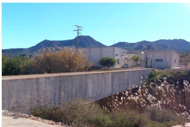
Imagen 12. Entrada del canal del ATS al depósito de la MCT en Tentegorra
