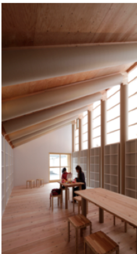
Figura 5 – Escola, posto de saúde e templo construídos com tubos de papelão, segundo o projeto de Shigeru Ban
