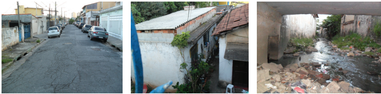
Figura 14 – À esquerda, bocas de lobo denunciam a presença de um córrego oculto. No centro, rebaiamento abrupto do lote é outro indicio da rede hídrica subterrânea. À direita, encontro com o poluído córrego Tabatinguera. Fotos do autor.
