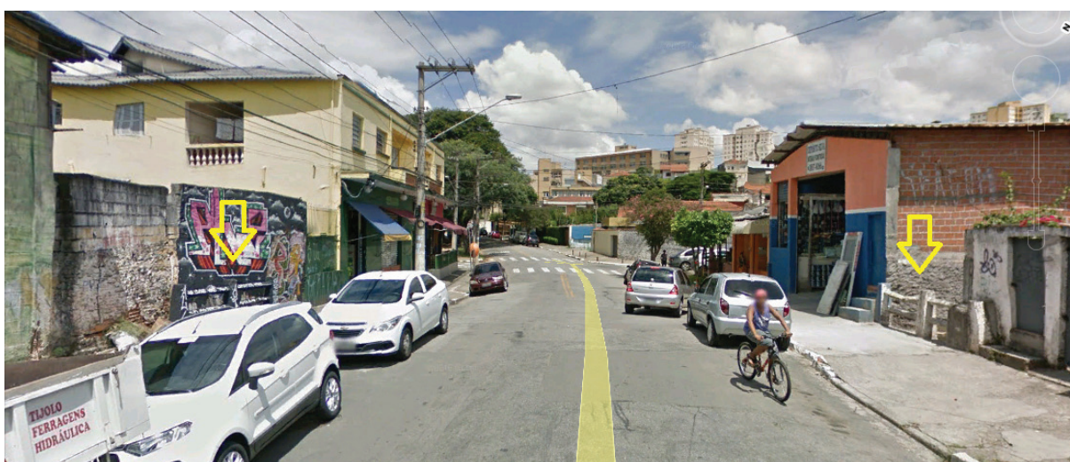
Figura 6 – Na rua Carolina Soares, o córrego Tabatinguera, afluente do Mandaqui, permanece a céu aberto de um lado da rua e oculto do outro. Com isso, guardacorpos idênticos assumem significados diferentes: é elemento funcional à direita e surreal à esquerda já que está encostado em um muro. Fonte: Google Street View.
