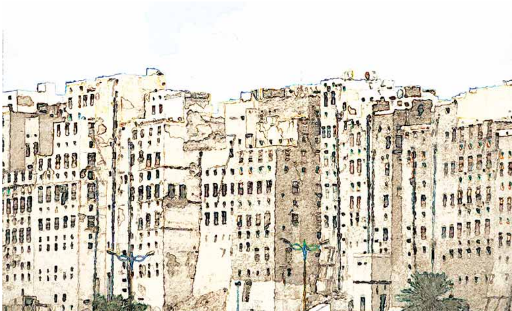
Figura 5 – Cidade de Shibam Hadramaut, Iemen. Alta densidade e edifícios agrupados para sombreamento durante o dia. Material de base pesado para amortecer a amplitude térmica.
