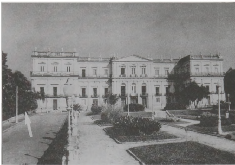
Fig. 12 – Fachada principal do prédio do Museu Nacional do Rio de Janeiro. A seta indica a localização do Jardim das Princesas.
