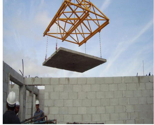
Figura 7. Laje sendo posicionada horizontalmente. Foto cedida pela construtora.
