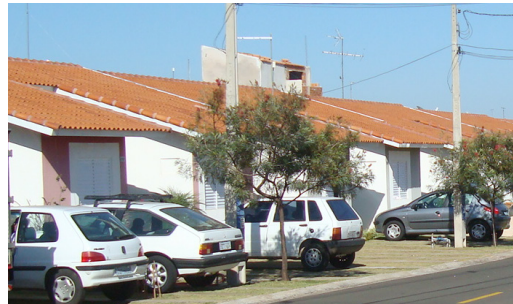
Figura 3. Vista das residências geminadas.
