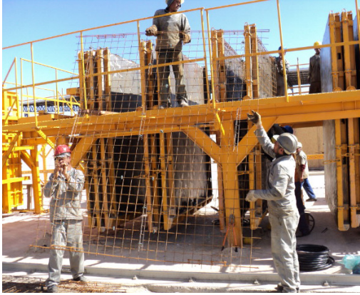
Figura 6. Lajes concretadas na vertical. Imagens cedidas pela Construtora.
