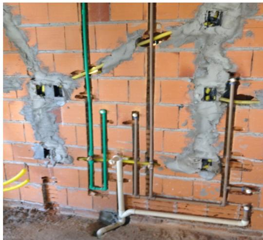
**Figura 4.** Prototipagem física para antecipar problemas de interferências entre subsistemas.
