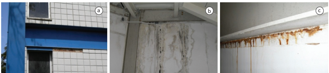
Figura 4. Manifestações patológicas identificadas na mesma parede; (a) descolamento de peças; (b) fungos em parede interna; (c) corrosão em parede interna.
