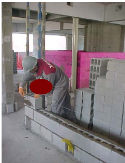
Foto 3: Detalhe da elevação
