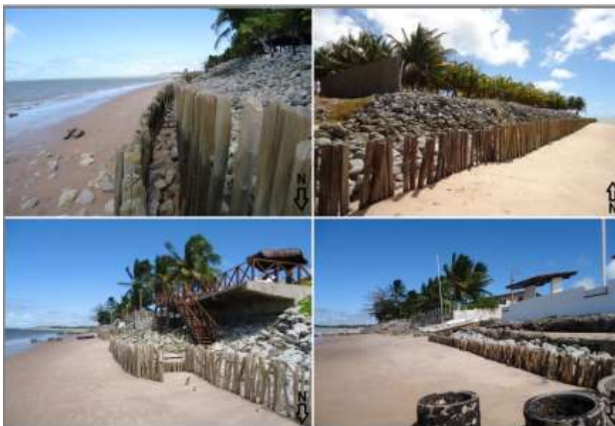
FIGURA 05: Aspectos dos arrimos construídos em imóveis residenciais na adjacência sul da Ponta do Seixas.
