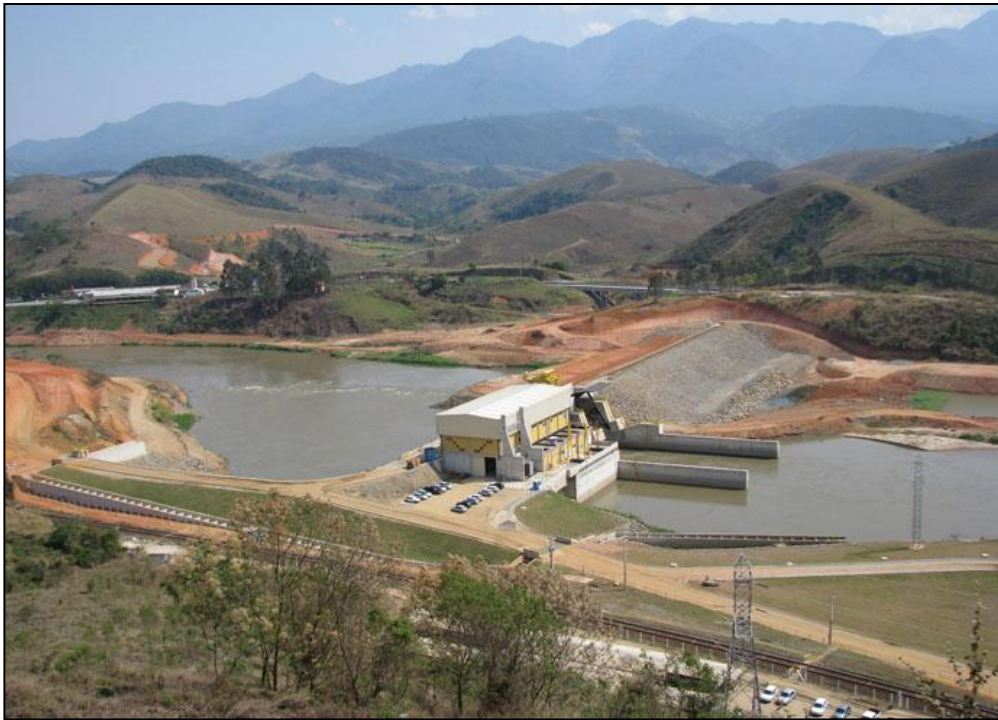
Figura 3 - A PCH-Queluz em operação (HABTEC, 2012).
