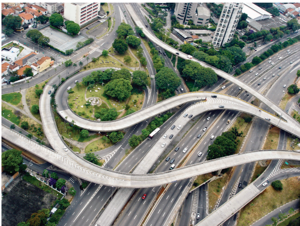
No alto, exemplo da verticalização sem limites em bairros assobradados: condomínio murado com equipamentos coletivos próprios. Embaixo, a cidade do automóvel.
