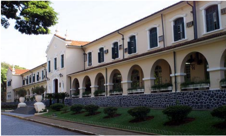
Vista do prédio da Faculdade de Medicina de Ribeirão Preto - USP.
