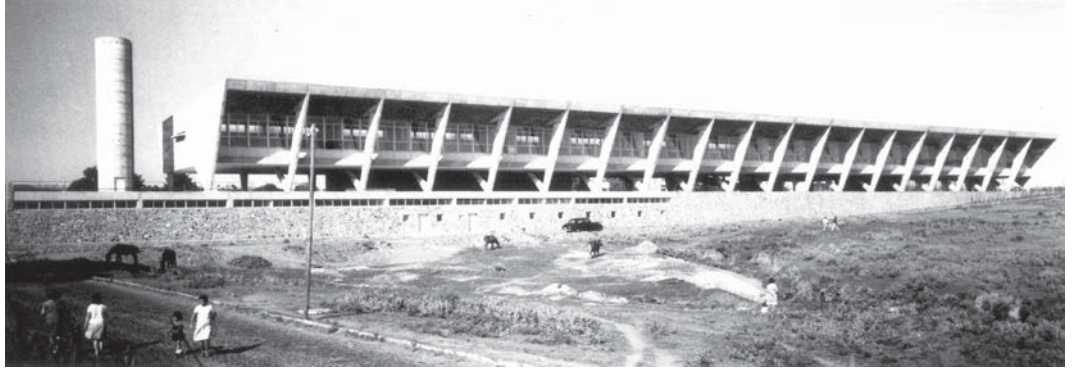
Figura 12: Affonso Eduardo Reidy, Escola Experimental Brasil-Paraguai, Assunção, 1952. Vista do bloco das salas de aula. Fonte: Bonduki (2000).
