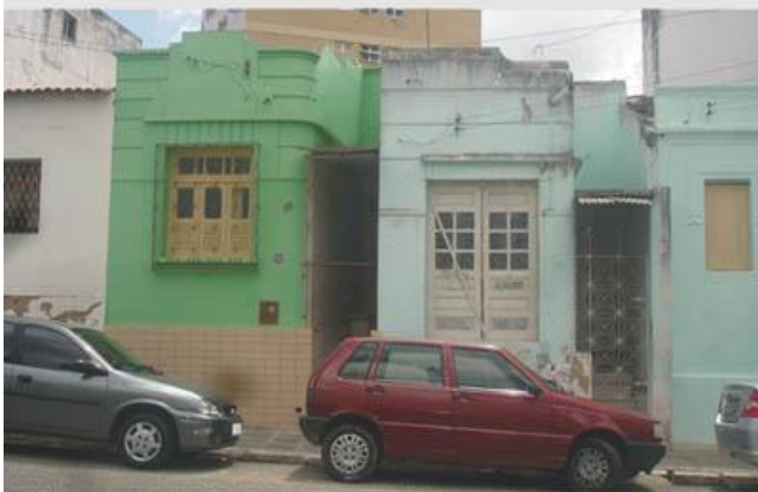
Figura 06: Acima e ao centro, conjunto de casas na rua Otacilio de Albuquerque, 1934. Abaixo, casas na rua Major Juvino do Ó. Fontes: Arquivo Público Municipal de Campina Grande. Fotos do autor.
