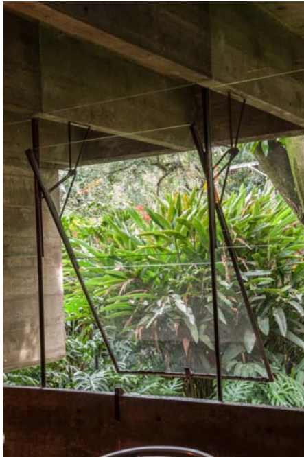
Figura 5: Vista do caixilho em detalhe. Fonte: Lauro Rocha.
