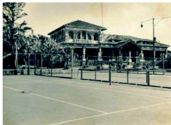
Figure 2: Baiano Tennis Club – n.d.; Source: Fundação Gregório de Mattos/PMS
