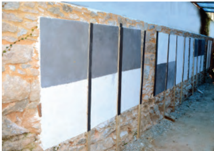
Figura 9: Vista geral da parede-teste Fonte: Arquivo FCRB, por Cláudia Carvalho
