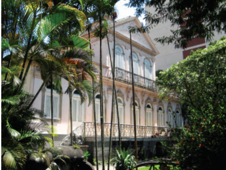
Figura 1: Fachada principal Museu Casa de Rui Barbosa, dezembro 2011 Fonte: Arquivo FCRB, por Thiago Turino
