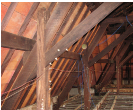
Figura 7: Visita de levantamento técnico no porão do edifício Vila Penteadado (FAU-Maranhão) Crédito: Acervo Conselho Curador
