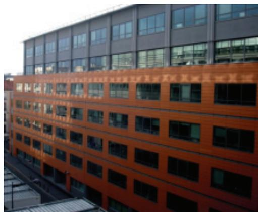
Figura 3: Fachada semicortina (após renovação), cujos componentes de fechamento são placas cimentícias com acabamento incorporado
