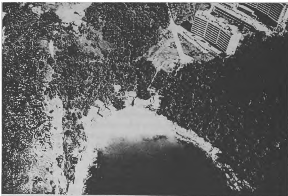
Serviço de terraplenagem, com a execução de cortes, aterros, com desmonte parcial do relevo, expondo os horizontes mais sensíveis do solo, favorecendo atividades erosivas.
