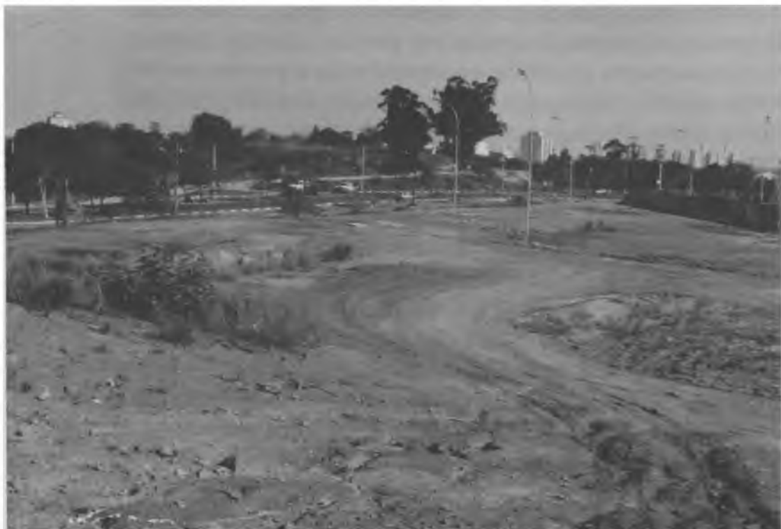
Foto 3 - Extensão do movimento de terras.
